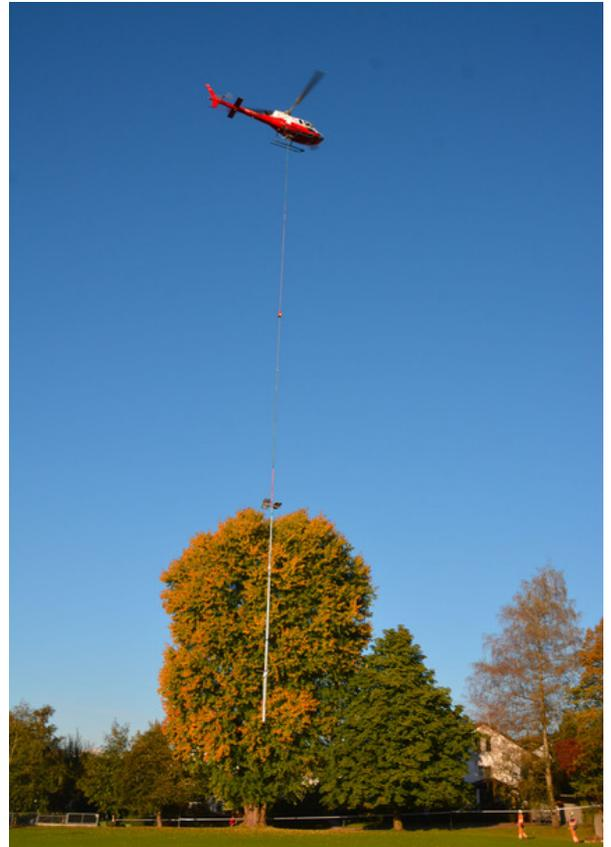
..... bei einer Länge der Kandelaber von 14 Metern und einem Gewicht von 650 Kilogramm .....
