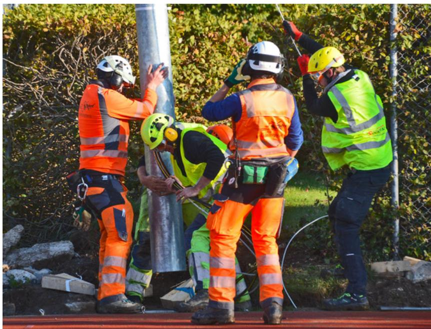
..... die Kabel eingefädelt und die Kandelaber provisorisch gesetzt.
